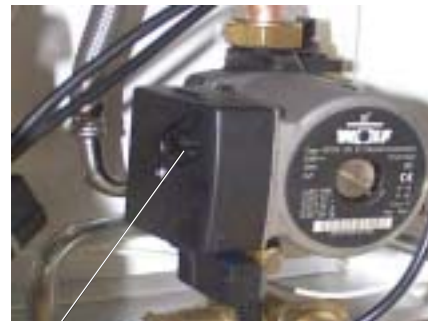
Wahlschalter für Pumpenstufe
