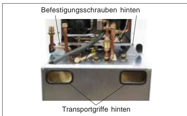
Bild: Transportgriffe an Speicher hinten
