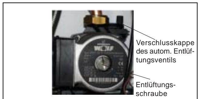
Bild: Automatisches Entlüftungsventil an der Heizkreispumpe
