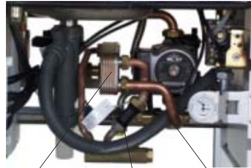
Plattenwärmetauscher Durchflusssensor Verteilerblock
