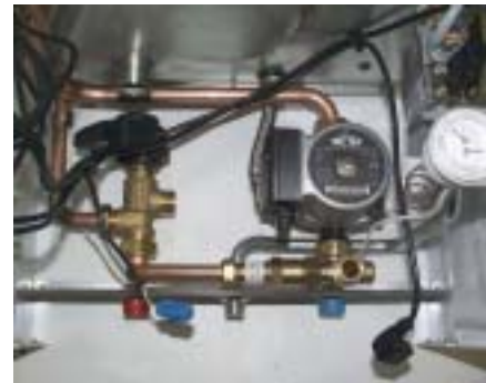
Bild: Anschlussblock demontiert
